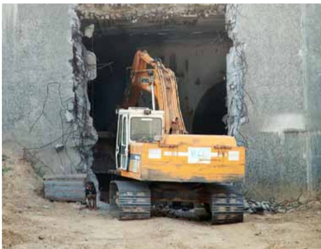
Рис.8 «Добыча металла» из инженерных конструкций
